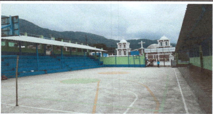
Foto No. 3 Cancha polideportiva ya fundida.
