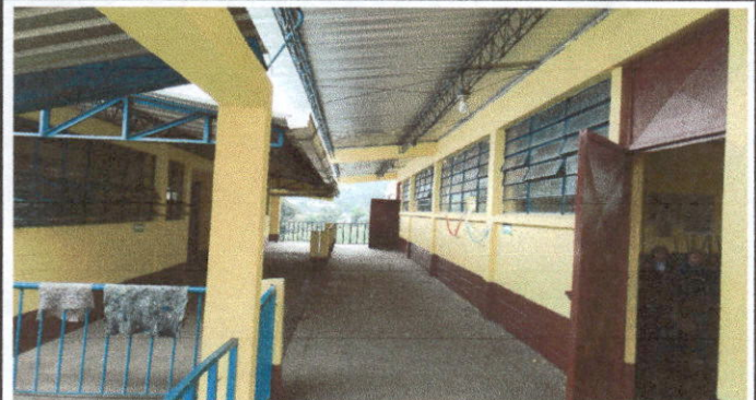
Foto No. 2 Cambio de techo de dos aulas finalizado.
