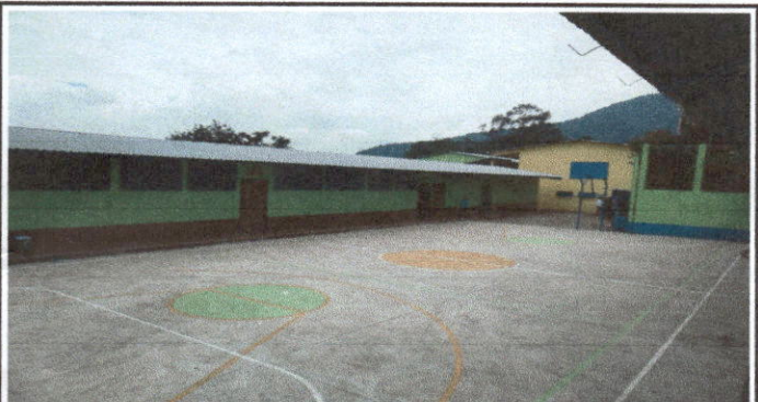
Foto No. 4 Cancha polideportiva ya finalizada.
