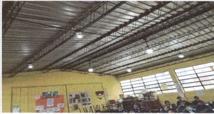
Foto No. 1 Cambio de techo de dos aulas finalizado.
